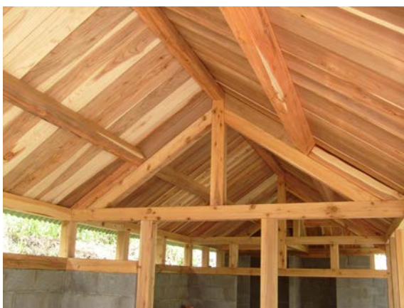
Ceiling frame, La Réunion (France).
