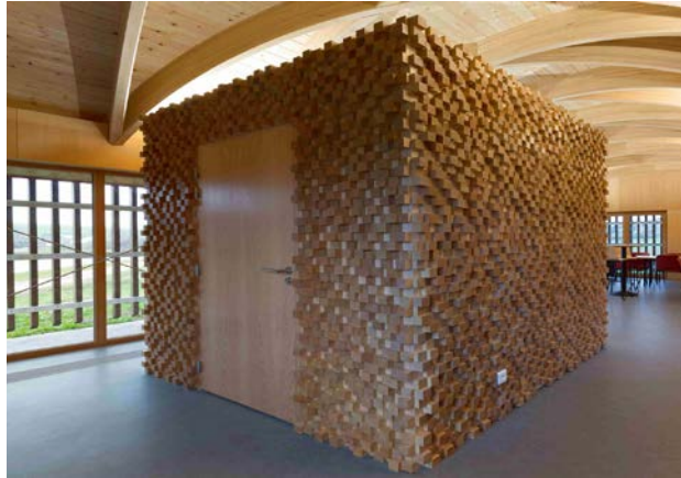
Glued laminated timber and interior décor in beech and common spruce: Les Woodies, holiday homes and technological showcase for beech wood construction, Terres de hêtre®; Communauté de communes de la Vôge, vers les rives de la Moselle, Xertigny (France).
